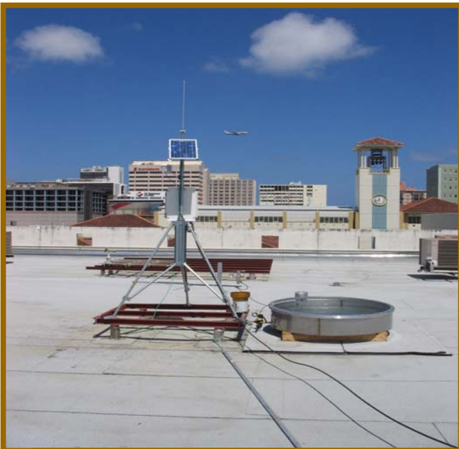
Evaporímetro y sistema automatizado de adquisición de datos en el techo del Edificio de Laboratorios
