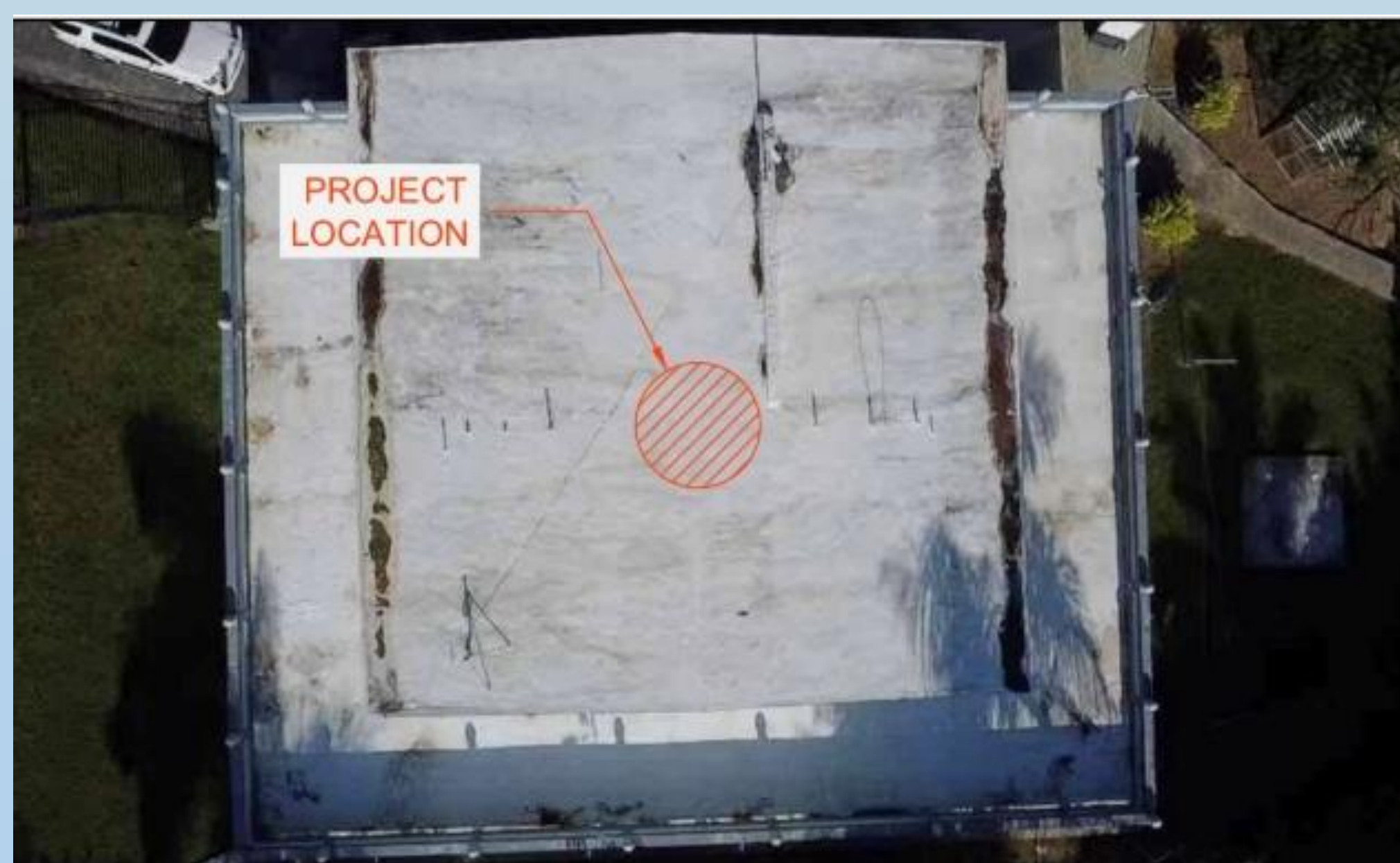
Figura 3: Techo de la Estructura
